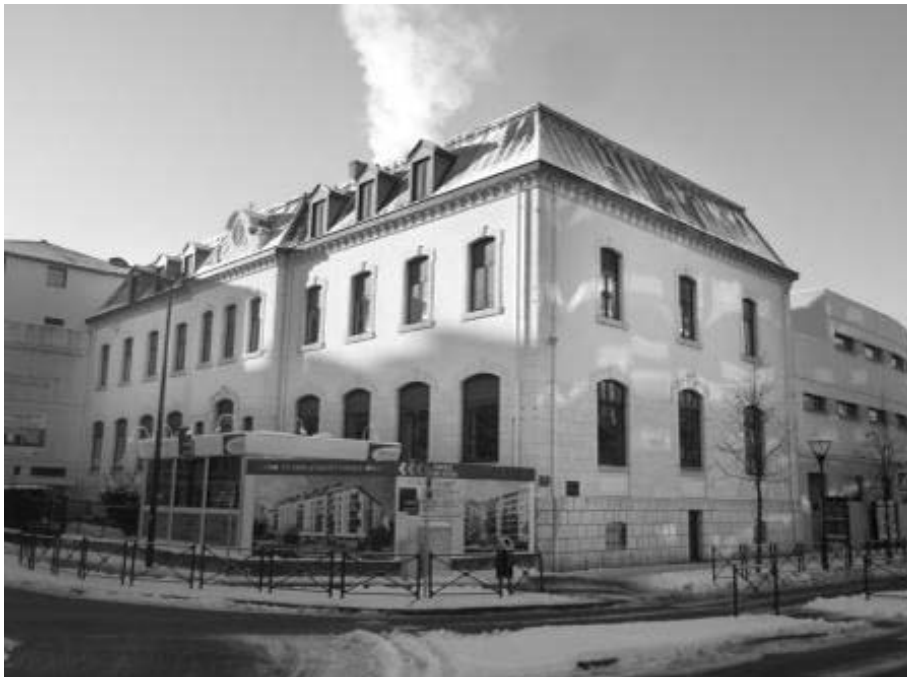
L'école Saint-François, avant sa démolition.
